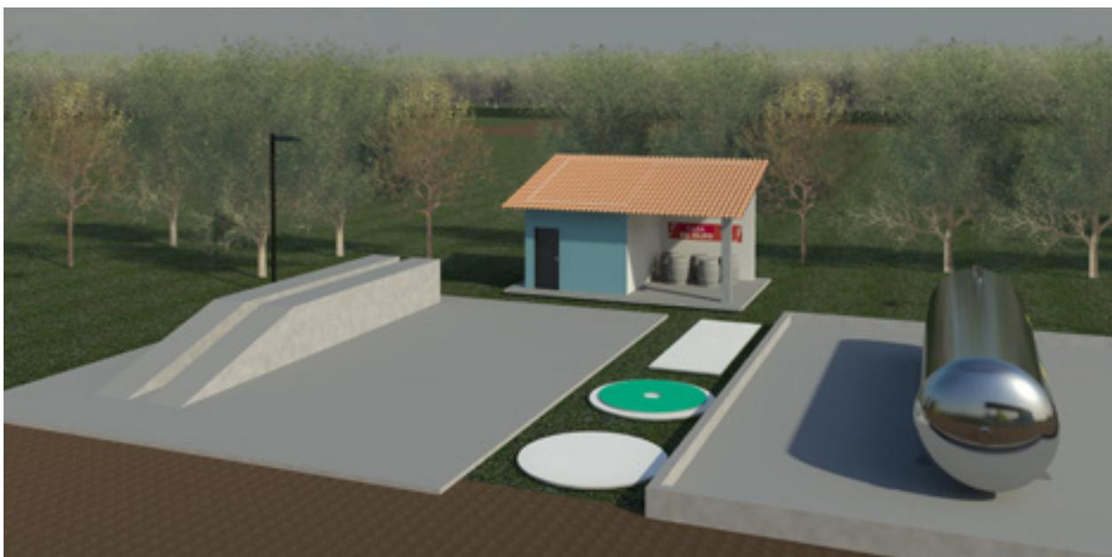
Este local deve ser utilizado para a troca de óleo das máquinas e lavagem de peças quando o barracão de máquinas não possuir a estrutura adequada composta por canaletas e caixa de separação.
