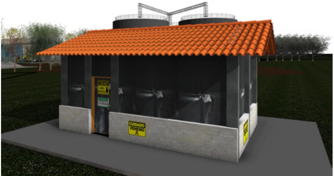
Quando o depósito for de alvenaria, não necessita de lona, porém deve-se manter a ventilação adequada, com aberturas superiores, utilizando tijolos vazados ou tela. Também deve possibilitar uma luminosidade adequada, descartando o uso de eletricidade.
